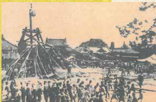
当時の石づき工事の様子
